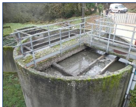
Décanteur/Digesteur + filtre à pouzzolane
